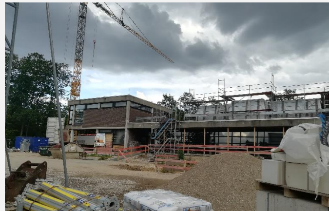
Die Bürgerhaus-Baustelle: Am Bürgerhaus selbst haben die Arbeiten noch nicht begonnen.
